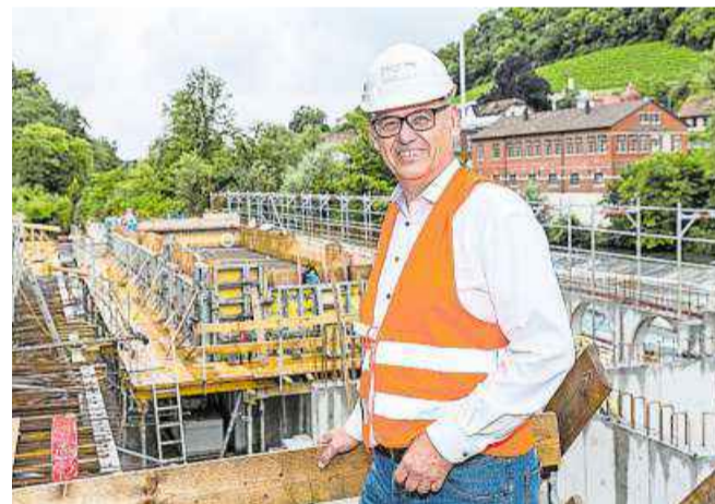
Herr über eine komplexe Grossbaustelle: Gesamtprojektleiter Anthony Strub auf dem Dach des neuen Thermalbads.
