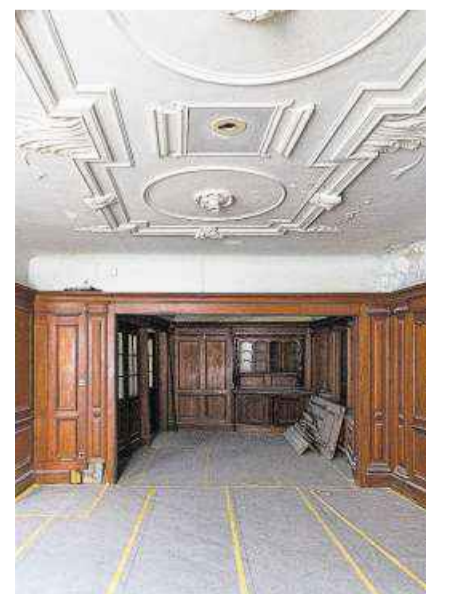
Alter Glanz in neuem Kleid: Stuck und Täfer werden im Verena-hof-Geviert wo immer möglich erhalten und restauriert.
