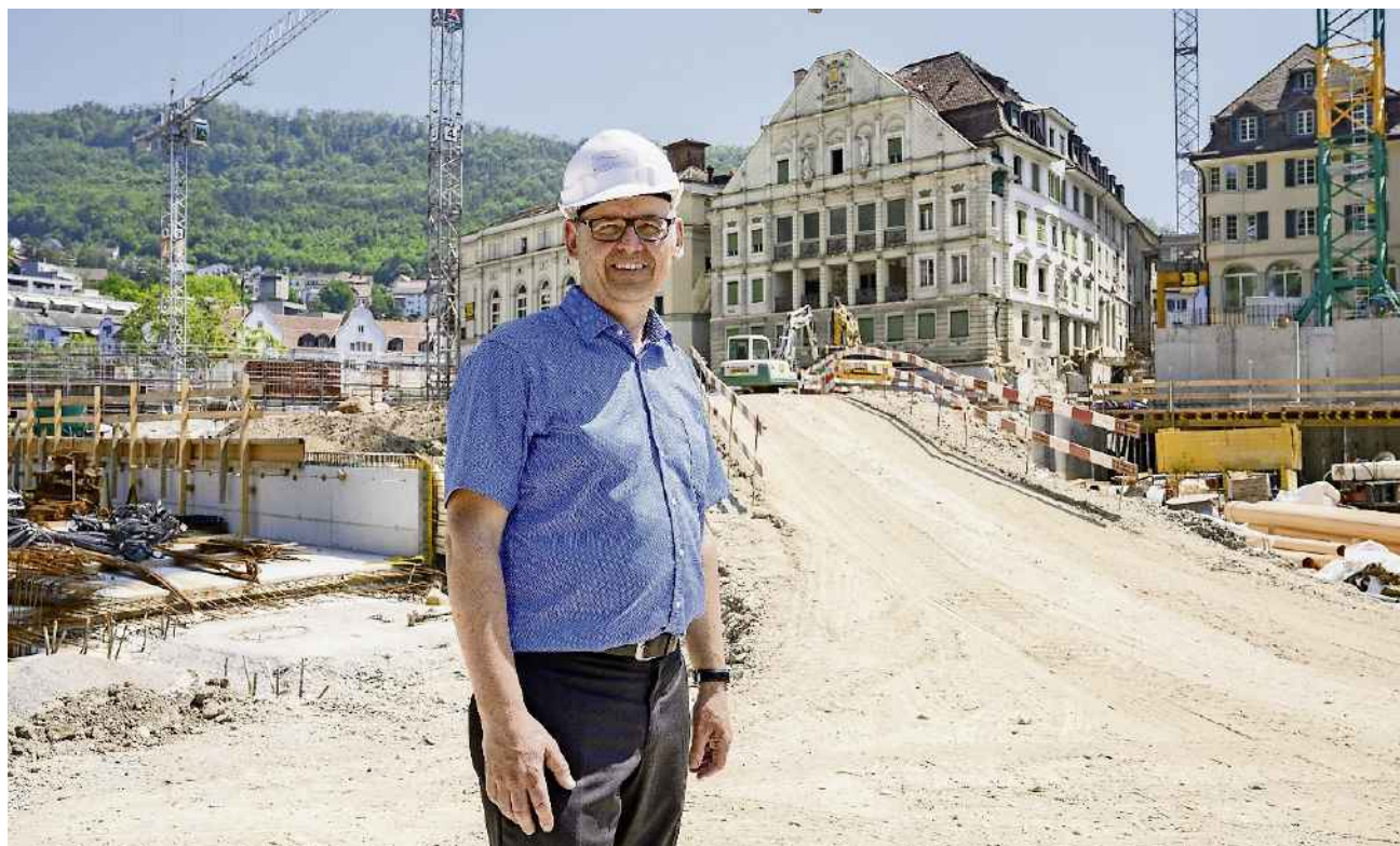
Gesamtprojektleiter Antony Strub: «Das Bild der Baustelle verändert sich fast täglich.»
