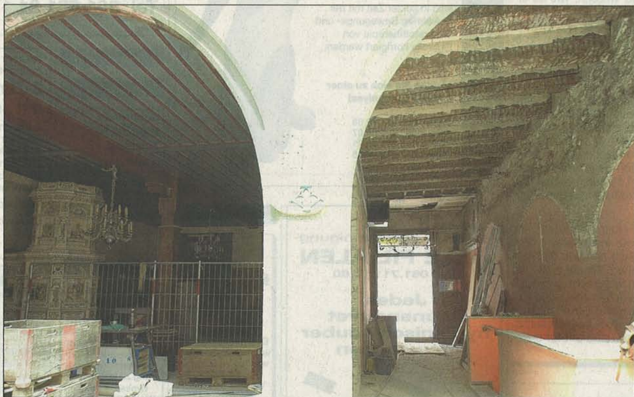
Links die verkleidete Decke, rechts der Eingang: Die Gewölbe sind weg, das alte Gebälk freigelegt.
